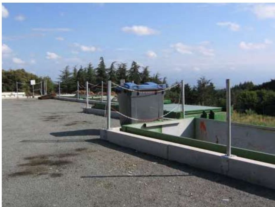
Εικόνα 6 Άποψη χώρων προσωρινής αποθήκευσης
