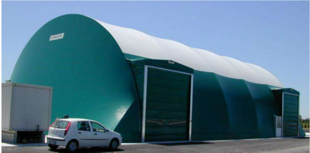
Εικόνα 35 Κτίριο Υποδοχής Εγκατάστασης
